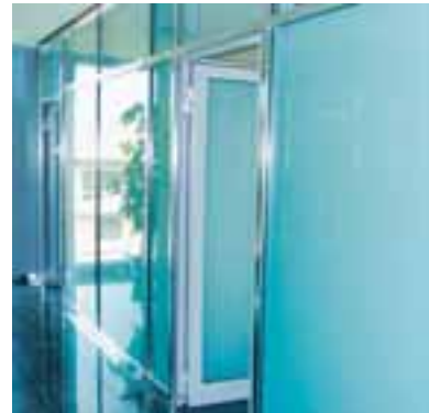
Innentrennwand FW 50 mit Edelstahl-Deckschale IW 50 interior partition wall with stainless steel cover cap
