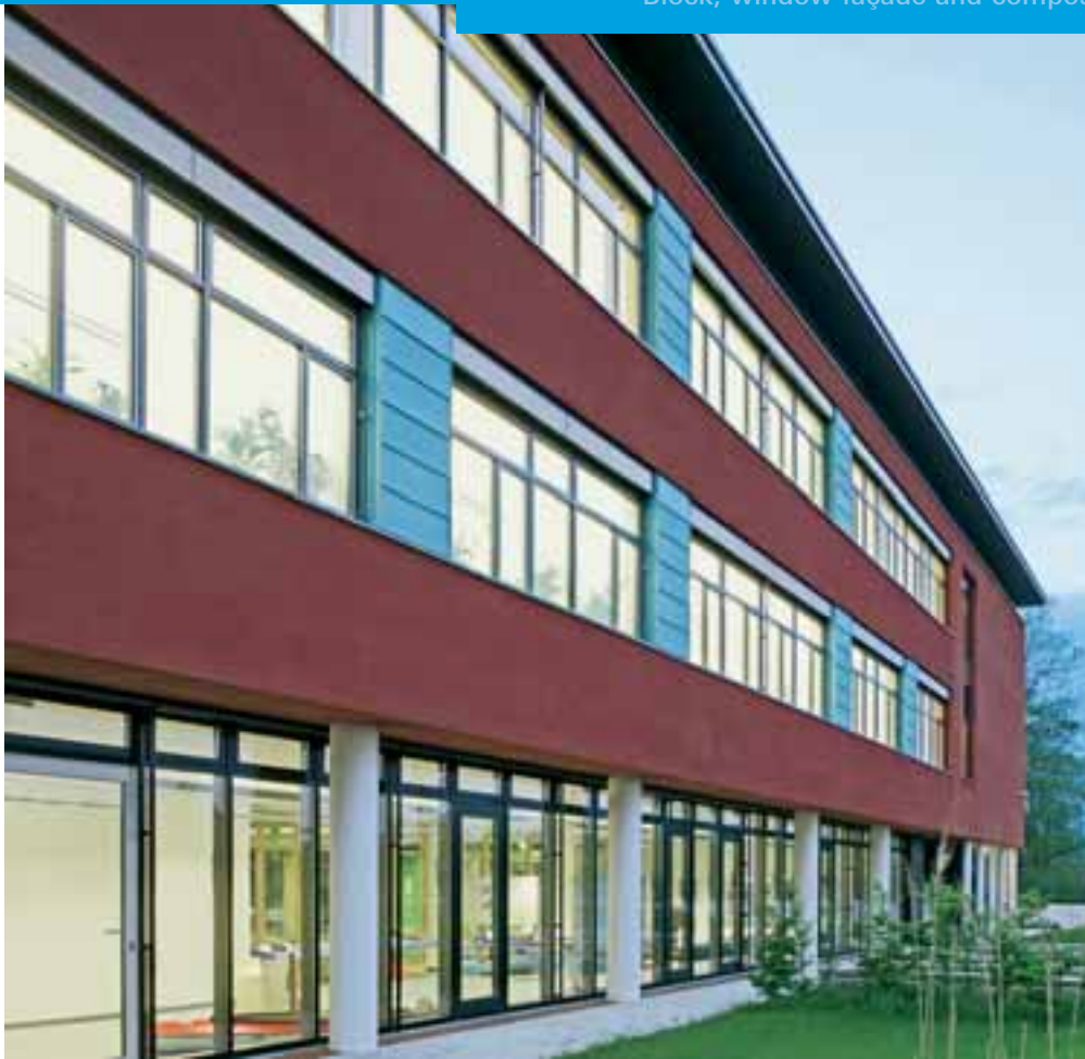
Gymnasium Schloß- Holte, Deutschland Schloß-Holte Gymnasium, Germany
